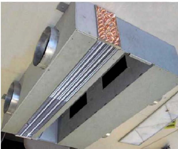
3. Démontez la plaque de fond / nettoyez par aspirateur l'échangeur thermique et le côté refoulement
